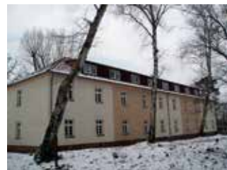
Wohnblock für Flüchtlinge in Mellensee; noch ohne Außenanlagen Ilona Friedland
